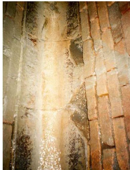
wird, stimmt mit dem Vorgang bei dem Bau eines neuen Kanals überein. Beim Ausbrechen der beschädigten keramischen Kanalarinnen und mehrerer Reihen vom beschädigten Ziegelmauerwerk wird die Stabilität des Kanals
